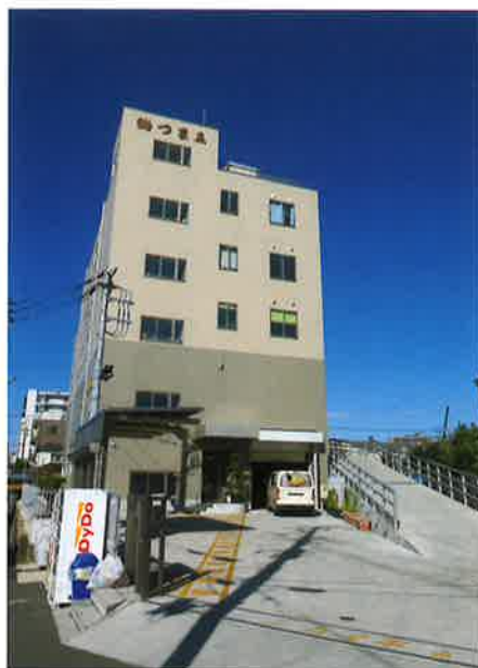
横浜市中央市場のすぐ前に2019年9月に竣工したつま正の本社ビル。1、2階に設けた配送センターは窓のない密閉空間で、完全コールドチェーン化されている。右手のスロープを上がった2階から搬入し、1階から搬出する。
